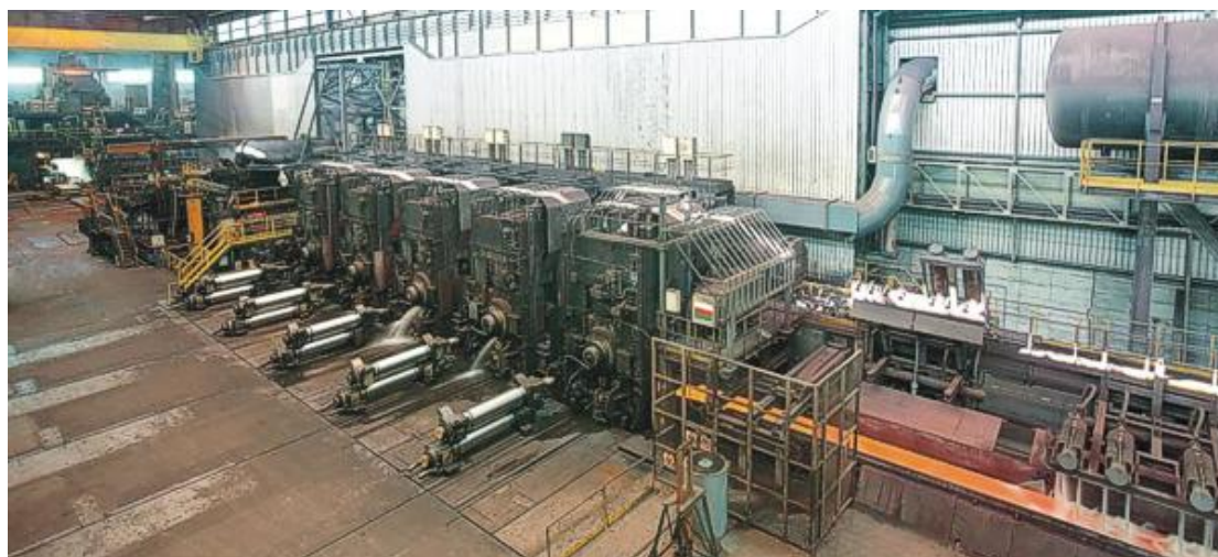
Рис. 3. Литейно-прокатный агрегат в Дуйсбурге
