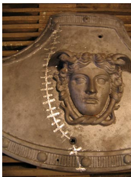
Рис.2. Отремонтированный щит ограды Екатерининского дворца
